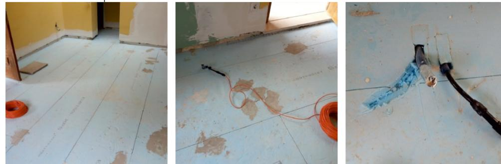
A união cabo quente/cabo frio do cabo de aquecimento deve ficar de forma que permita ser totalmente envolvida pela argamassa de regularização.
